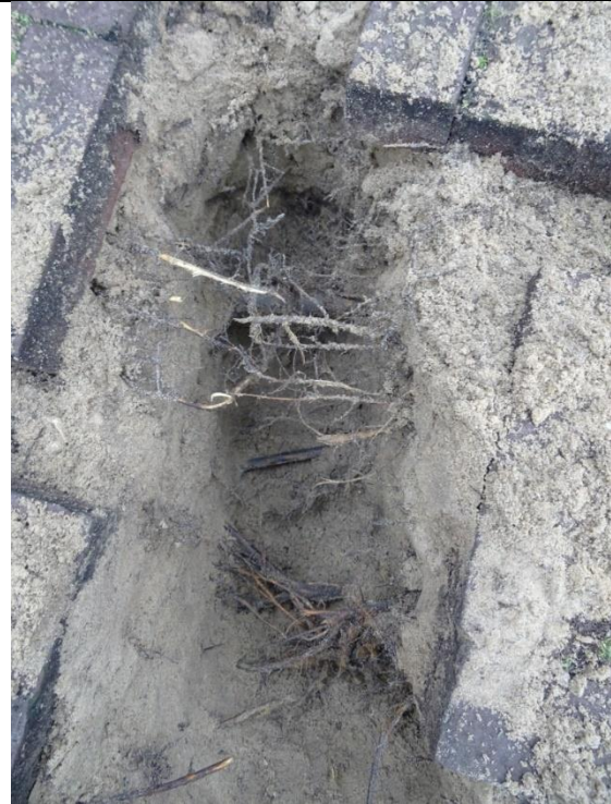
Matig intensieve beworteling direct onder de klinkers tot 25 cm-mv.
