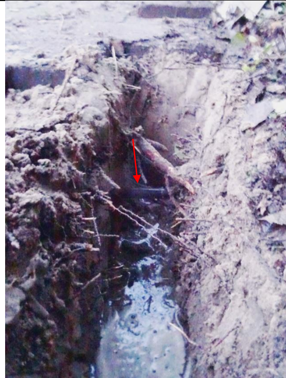
Intensieve beworteling direct onder de tegels tot 25 cm-mv. Bij de pijl loopt een zwarte tyleenslang. Op de voorgrond is het grondwater zichtbaar.
