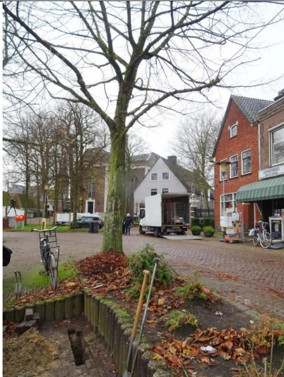
Ligging van de sleuf. In het veld zijn enkele wortels zichtbaar die tussen de palissaden door de bestrating in groeien.
